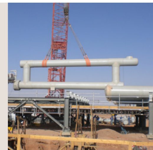
Montaggio di manifold e slug catcher, elementi prefabbricati nella cui produzione il Gruppo Allied è leader
